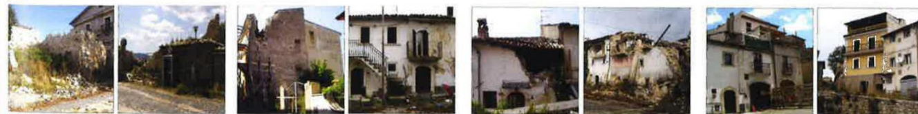
Edifici crollati totalmente o parzialmente. Aggregati 05 e 20-253
