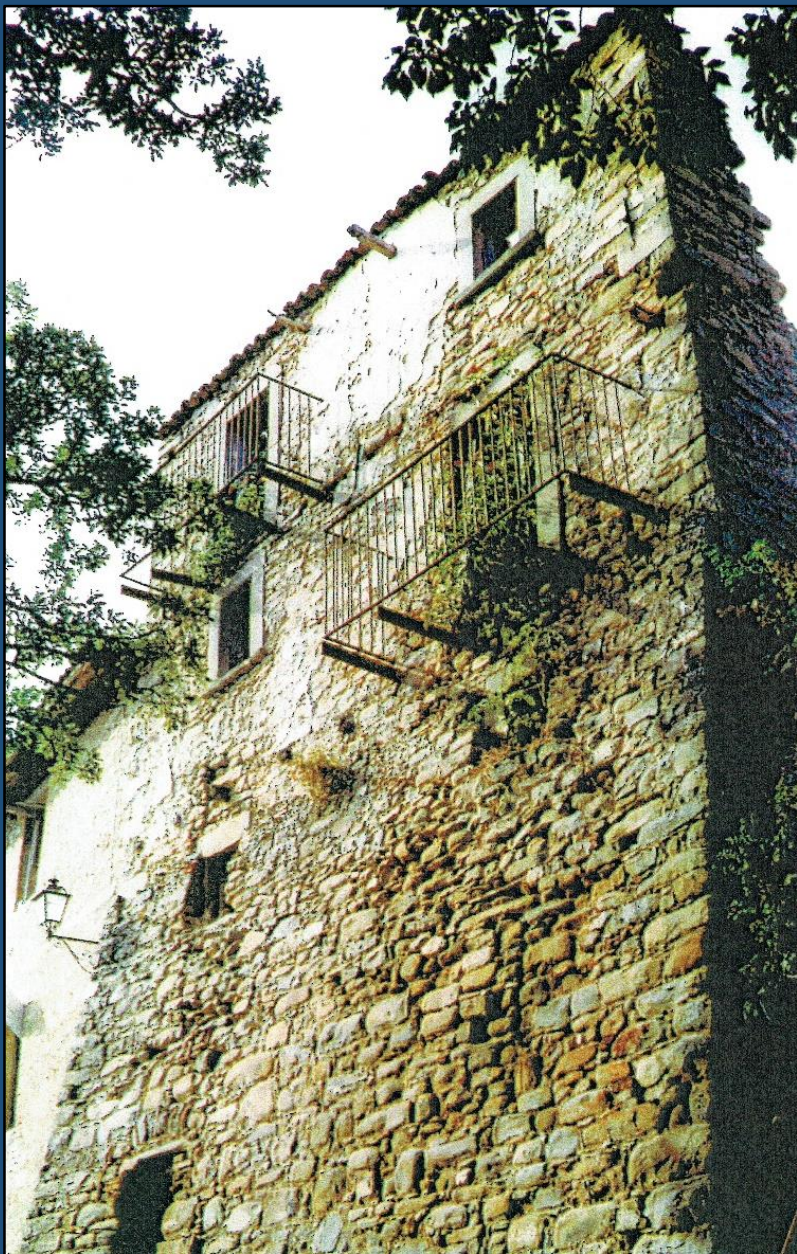
Vecchio edificio visto dalla Provinciale
