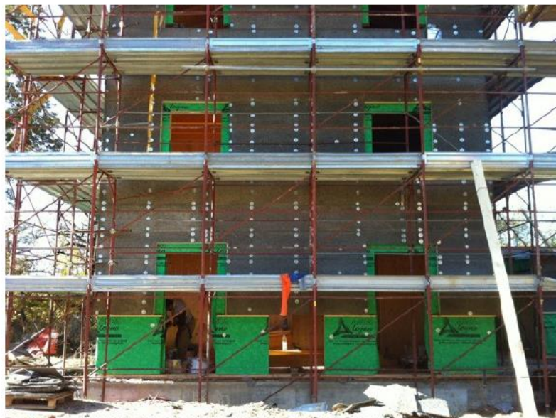
STRUTTURA PORTANTE ISOLANTE IN LEGNO (SPESS. 12,50 cm.) + RIVESTIMENTO A CAPPOTTO
