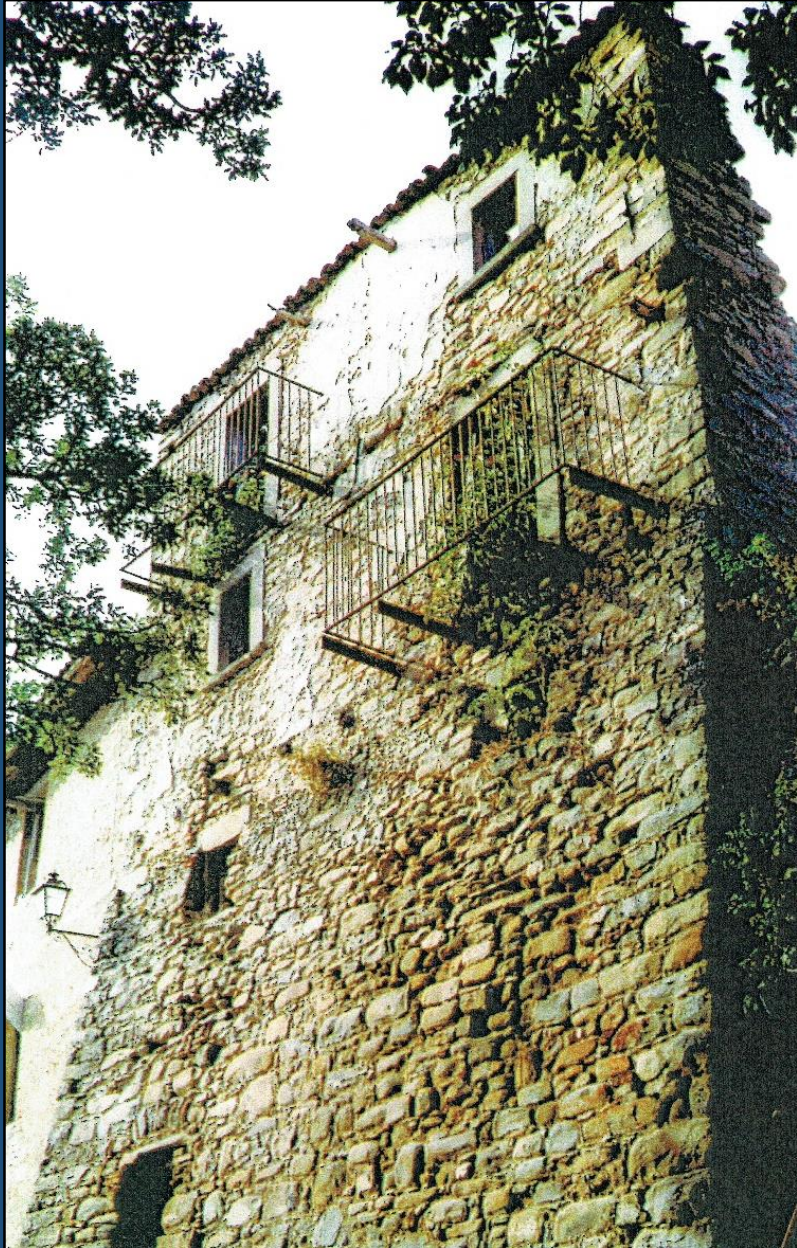
Vecchio edificio visto dalla Provinciale
