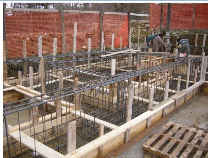
ARMATURA TRAVI DI FONDAZIONE
