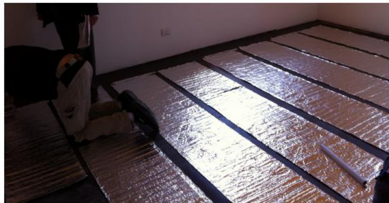
RISCALDAMENTO RADIANTE ELETTRICO A PAVIMENTO
