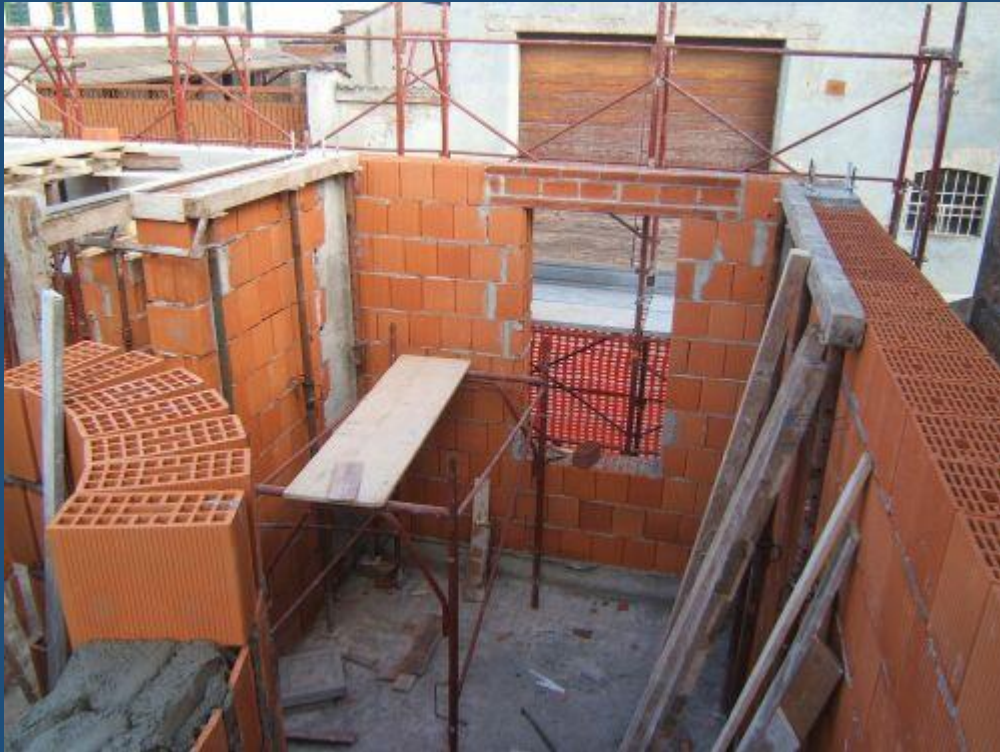
MURATURA in blocchi semipieni di laterizio
