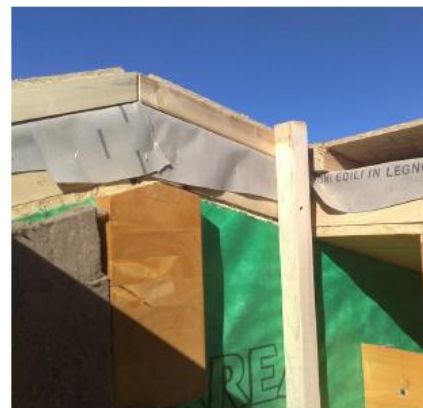
TETTO VENTILATO ED ISOLATO
