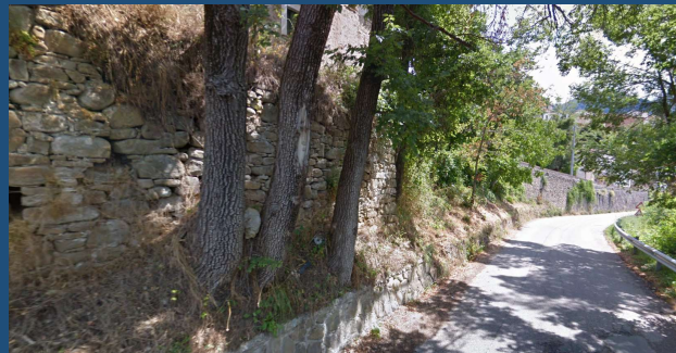
Muri e muretti di contenimento in pietra
